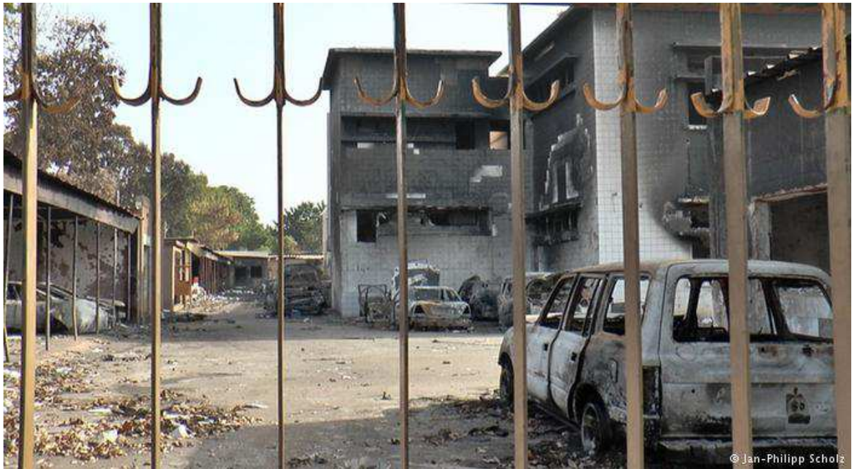
Das zerstörte burkinische Parlamentsgebäude in der Hauptstadt Ouagadougou
