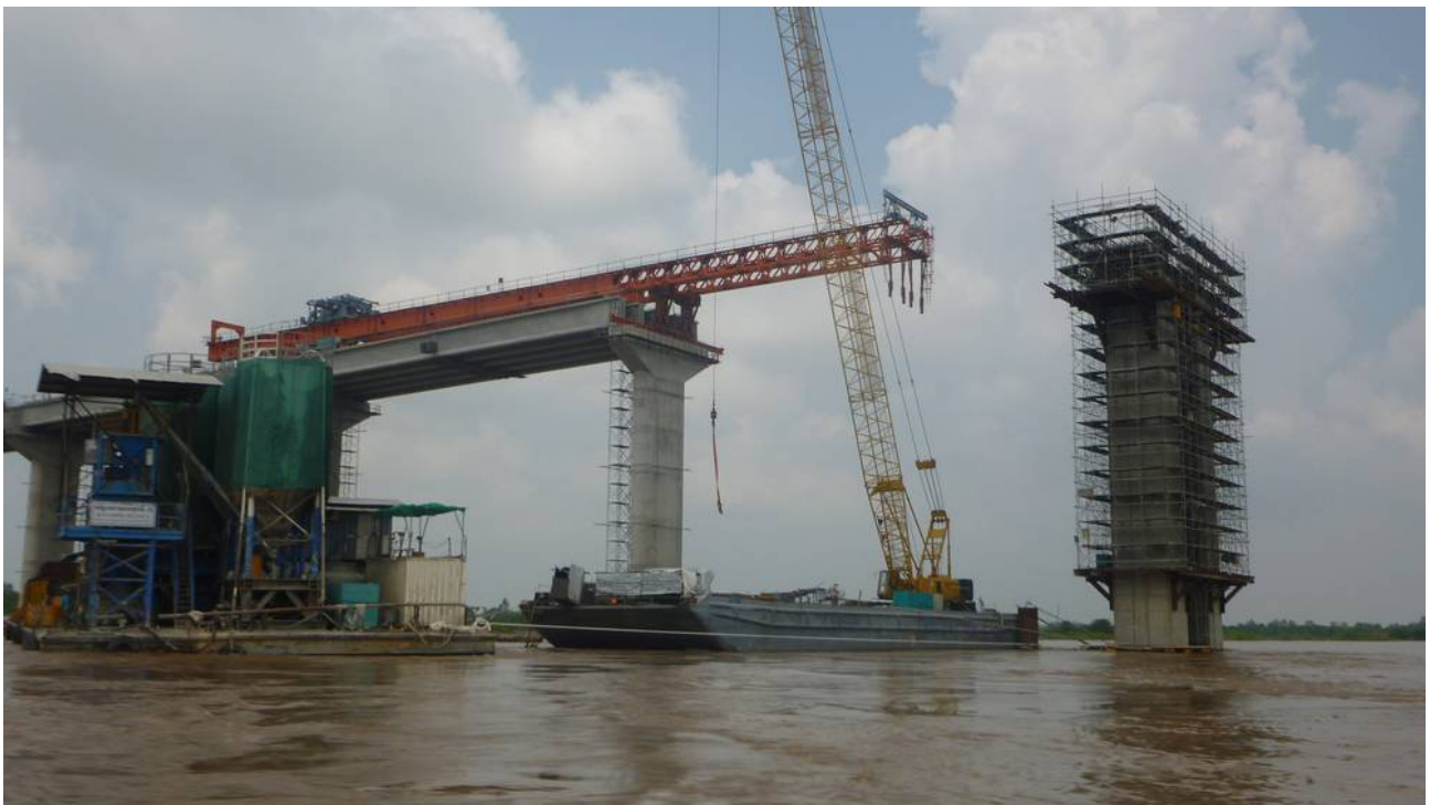
Bau einer Brücke über den Tonle Bassac, Provinz Takeo (Foto: Damien Farrell, (CC BY 2.0))
